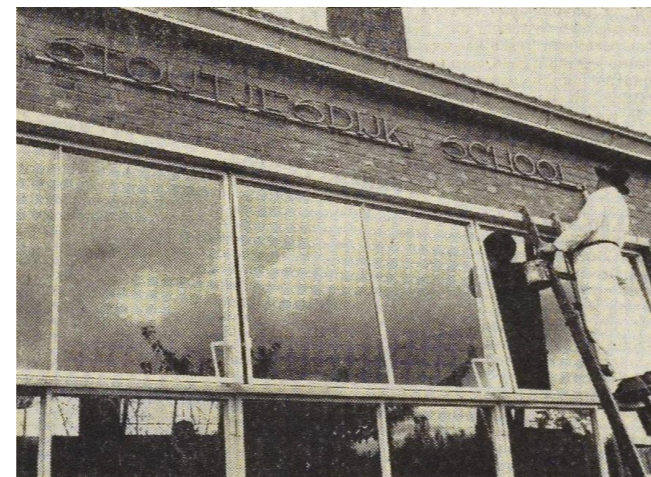
Krantenfoto van 21 oktober 1964, de nieuwe naam op de zuidzijde van het schoolgebouw wordt aangebracht.
